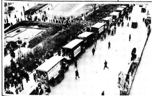
NEWARK, N. J.—Salida de la interminable fila de camiones que condujo al contingente de desocupados de los Estados de New York y New Jersey a Washington. (Fotos Int. News).
