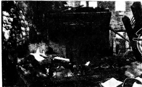
Un aspecto del edificio incendiado.
